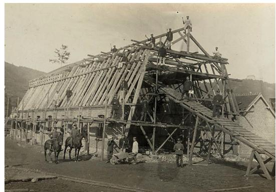
Abbildung 17: Bau einer Luftschiffhalle in Namur
